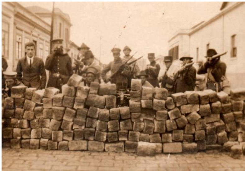
1 – Aspecto de uma trincheira urbana
