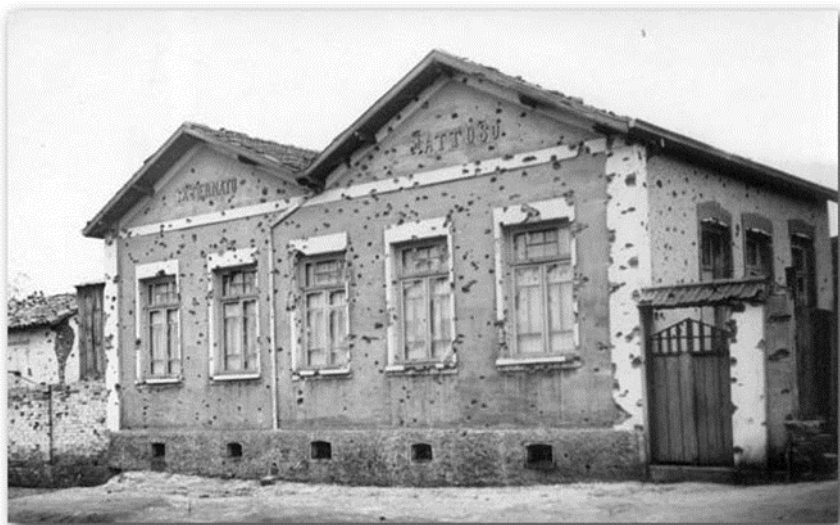
3 – Externato Mattoso – Rua dos Trilhos - Mooca
