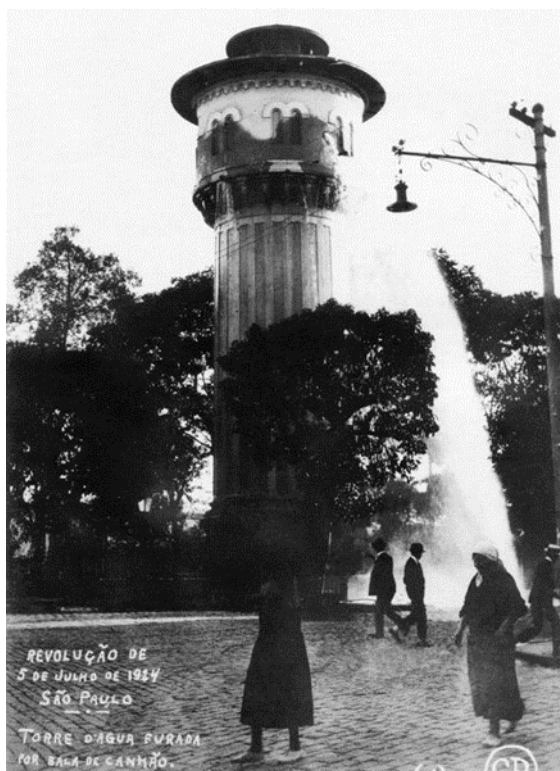
5 – Caixa d'água atingida por tiro de canhão
